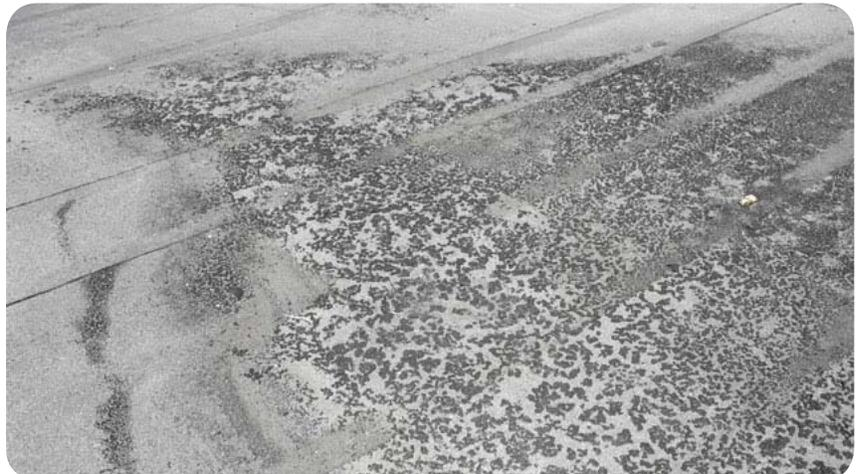
Image 18- Désagrégation d'une membrane élastomère à base de bitume de 10 ans d'âge
