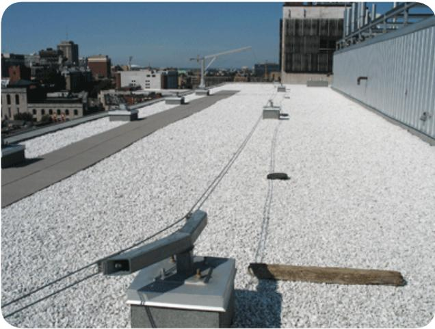
Image 16- Toiture inversée avec ballast blanc réfléchissant (Hydrotech) sur le pavillon des sciences biologiques à l'UQAM- Membrane en polyoléfine thermoplastique (TPO)
