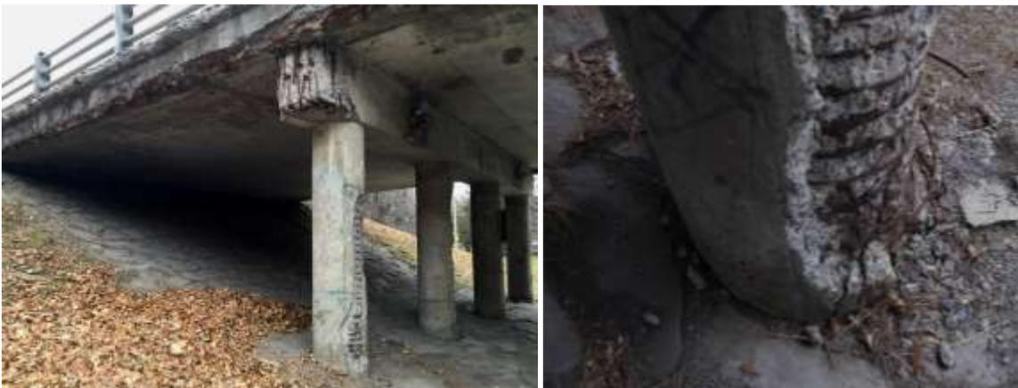
Dégradation avancée des ponts d'étagements Remembrance \ Chemin de la Côte-des-Neiges Photos DC
